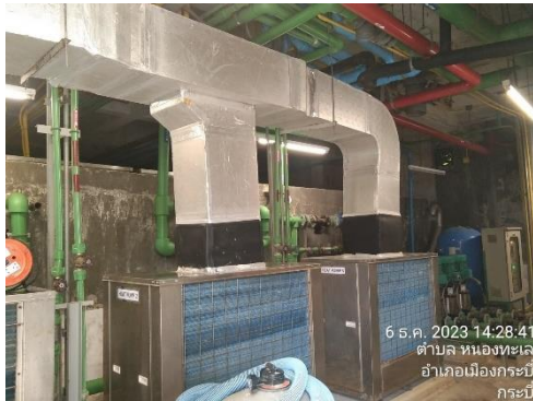
ระบบปรับอากาศแบบ VRF
