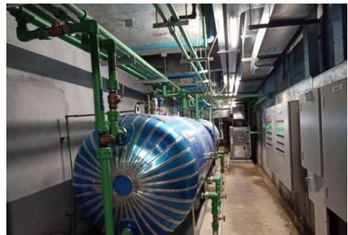
เครื่องทำน้ำร้อนแบบฮีทปั๊ม
